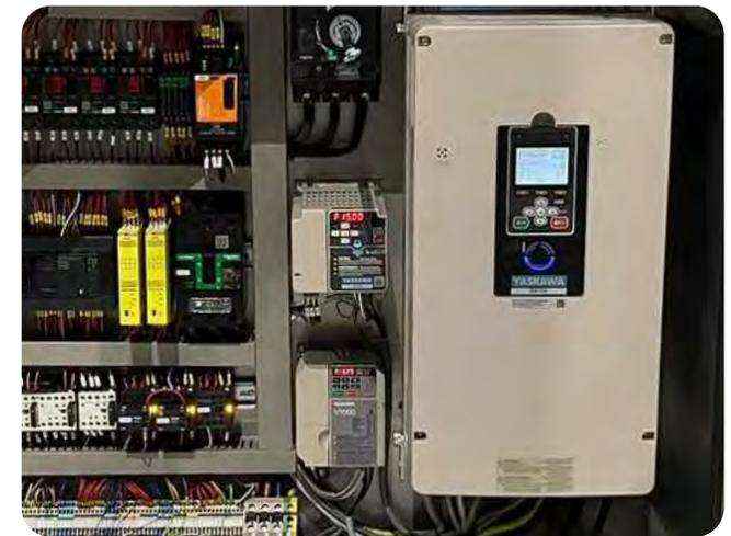
**Arranque y parada suave** de cuchillas y artesa mediante variadores electrónicos.
